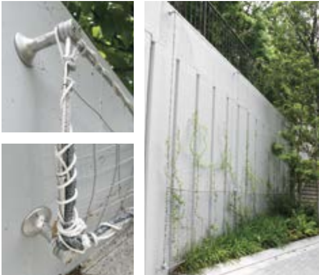
2ウェイグリッドラインにネットを取付けた施工事例
